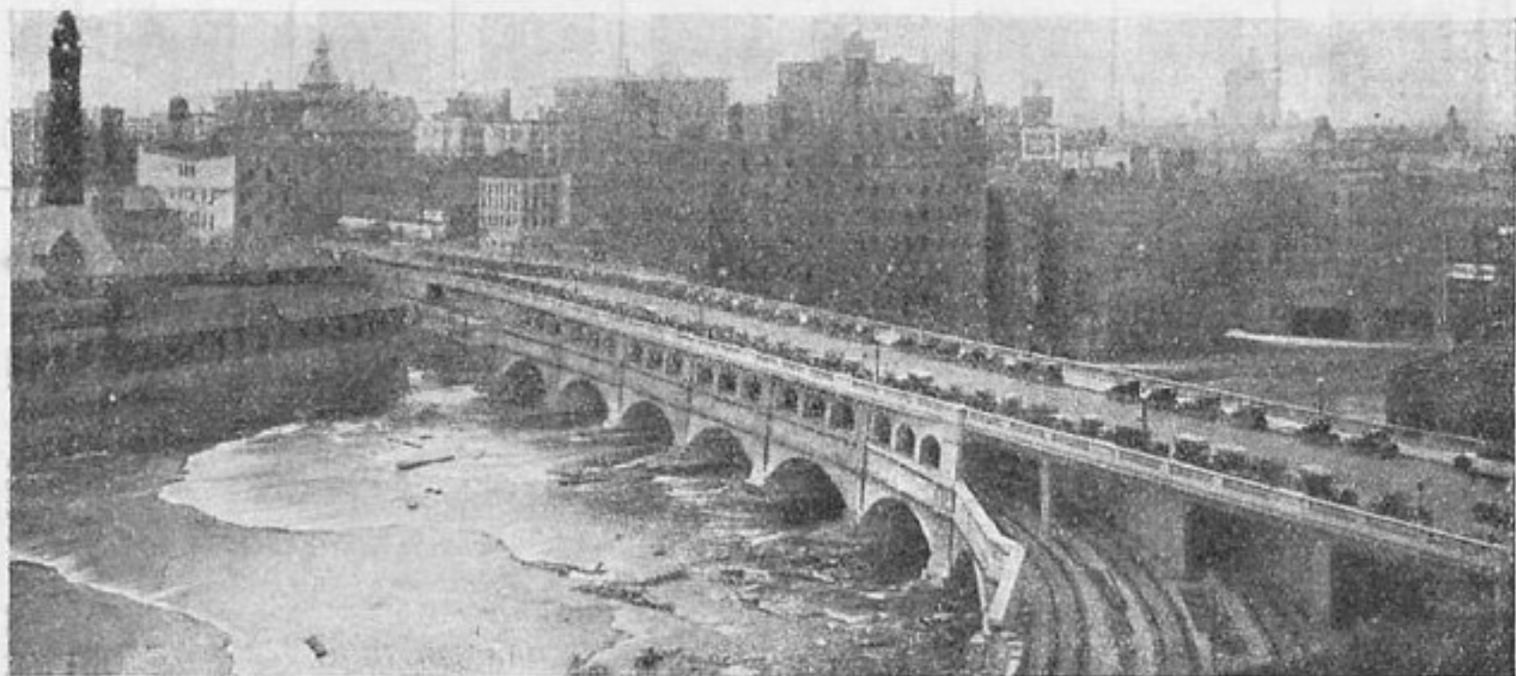
Автомобильная дорога в г. Рочестере, проходящая во втором ярусе — над эстакадой метрополитэна. Эта дорога, носящая название „Брод Стрит“ („широкая улица“) перекрещивается с другими городскими улицами в разных уровнях
